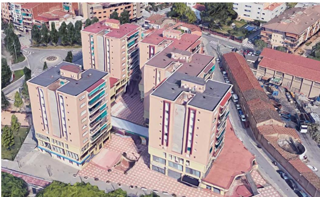
Vista aèria (simulada, a Google Earth ) del 'Complex Solarium'
